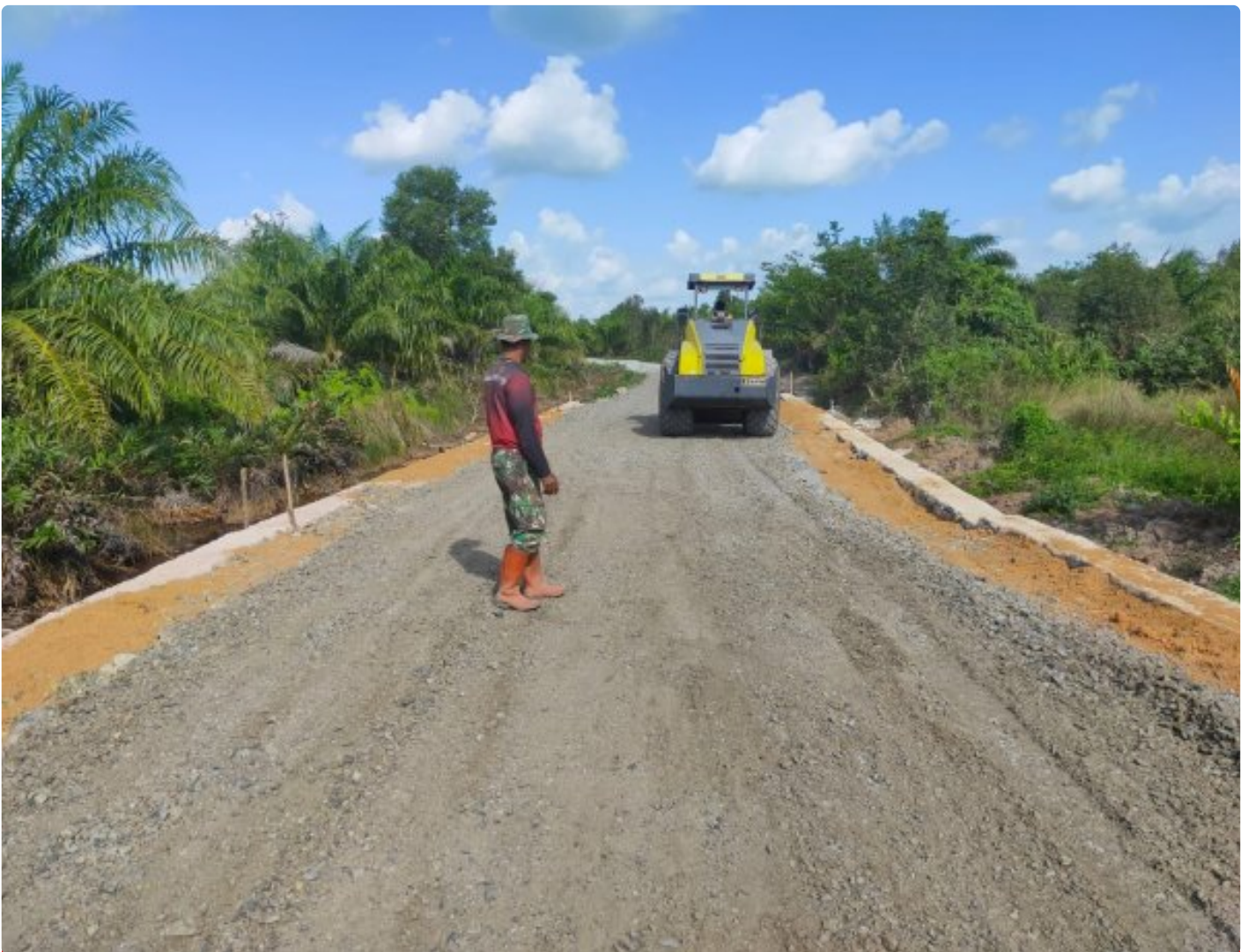
Percepat Pekerjaan, Vibro Dan Grader Dikerahkan Di Sasaran Pokok TMMD
