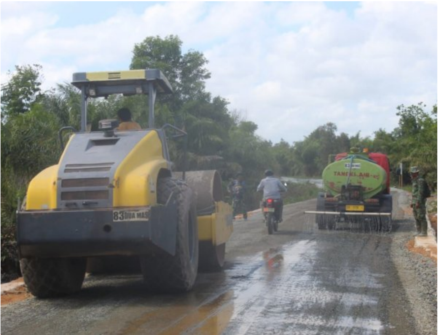
Memasuki Hari-Hari Terakhir, Pengerjaan Sasaran Jalan Di Kebut
