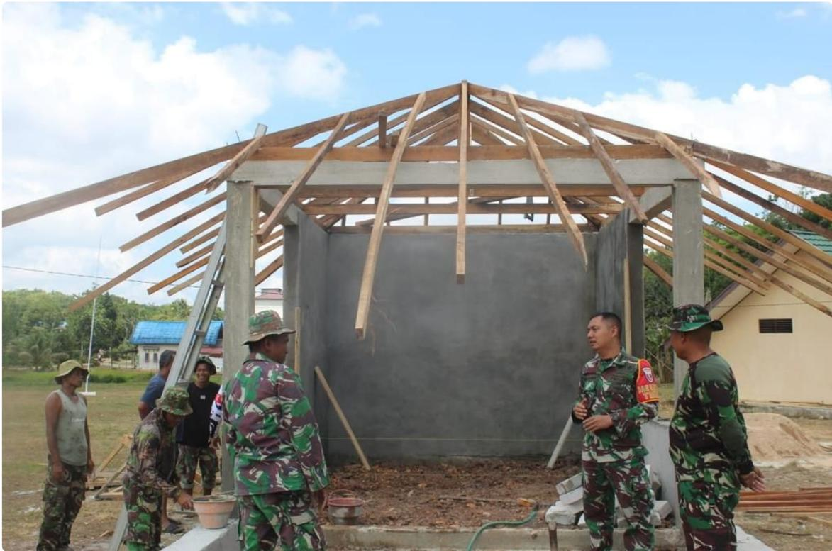
Saat ini pos kamling yang dibangun oleh Satgas TMMD ke-117 di Desa Telaga Langsung sudah memulai proses pemasangan rangka atap. Hal tersebut seperti yang disampaikan Dansatgas Letkol Inf Indar Irawan, S.E., M.Han., saat mengecek pembangunan pos kamling.
