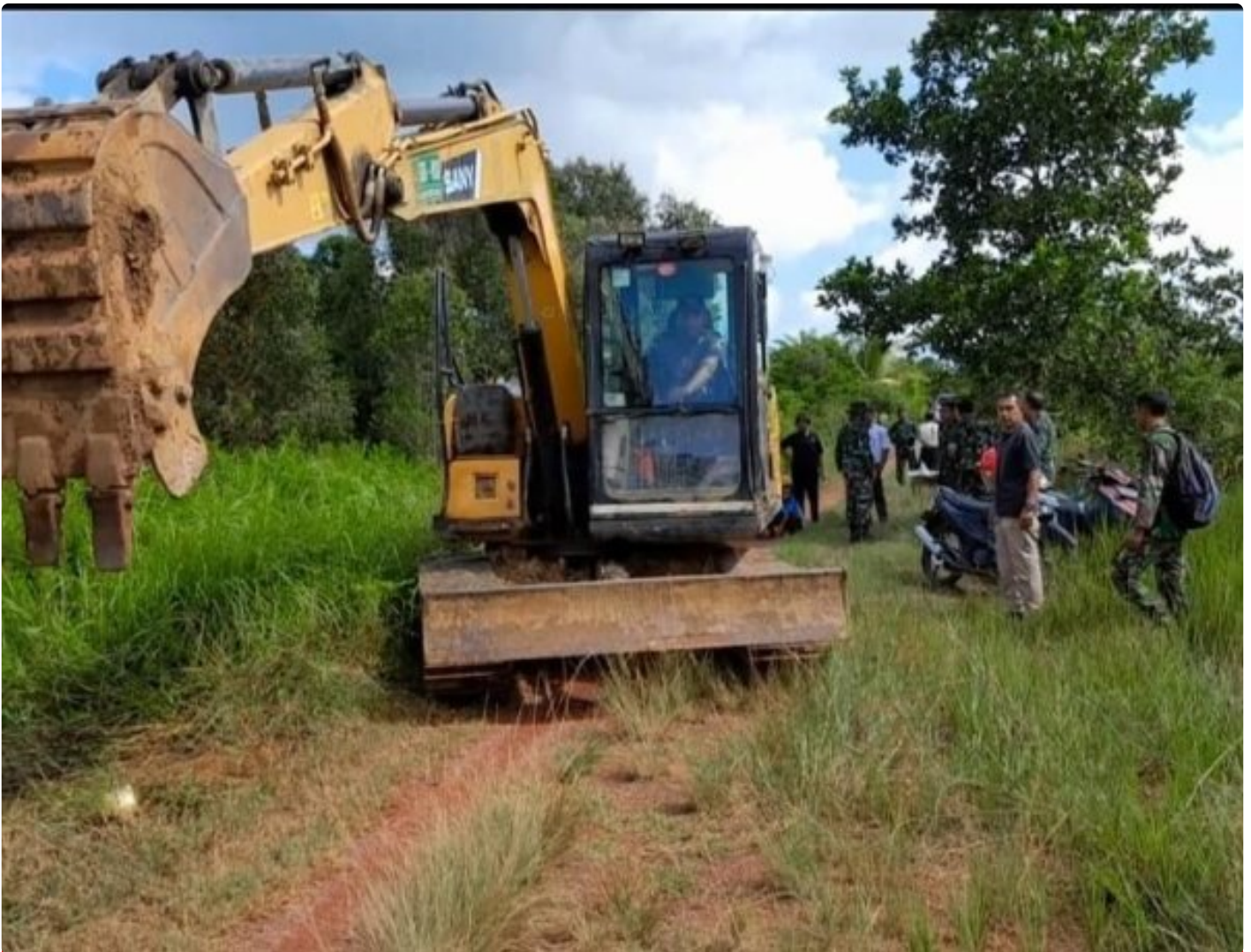
Dandim 1009/Tla, Turunkan Excavator Di Lokasi TMMD
